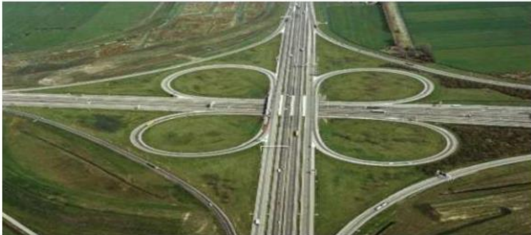
Figure 27 : Échangeur autoroutier en trèfle complet[12]
