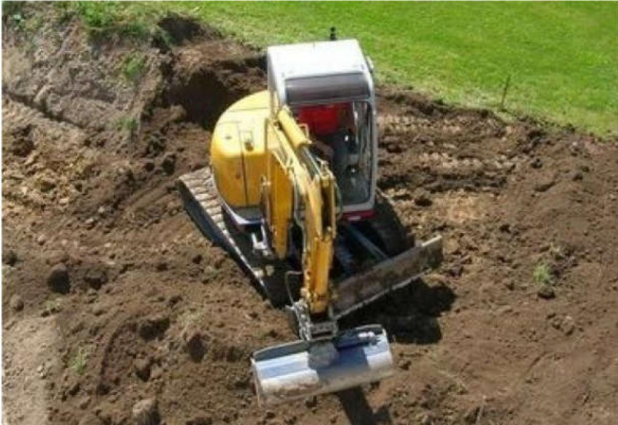
**Figure 23:** La stabilisation du sol avant mise en place des fondations d'une maison
