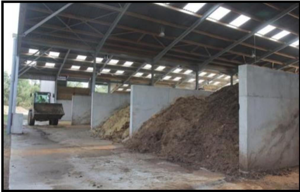
**Figure N°05** : de compostage fermée où les émissions de gaz peuvent facilement être capturées et nettoyées
