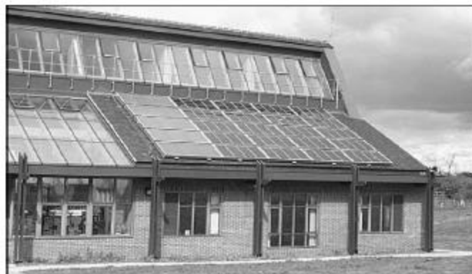
FIGURE 35 : CAPTEURS SOLAIRES COMBINES INTEGRES A LA TOITURE
