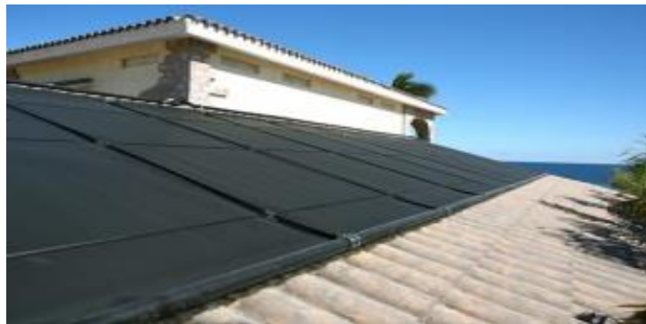
FIGURE 18 : SCHEMA D'UN CAPTEUR PLAN NON VITRE [37]
