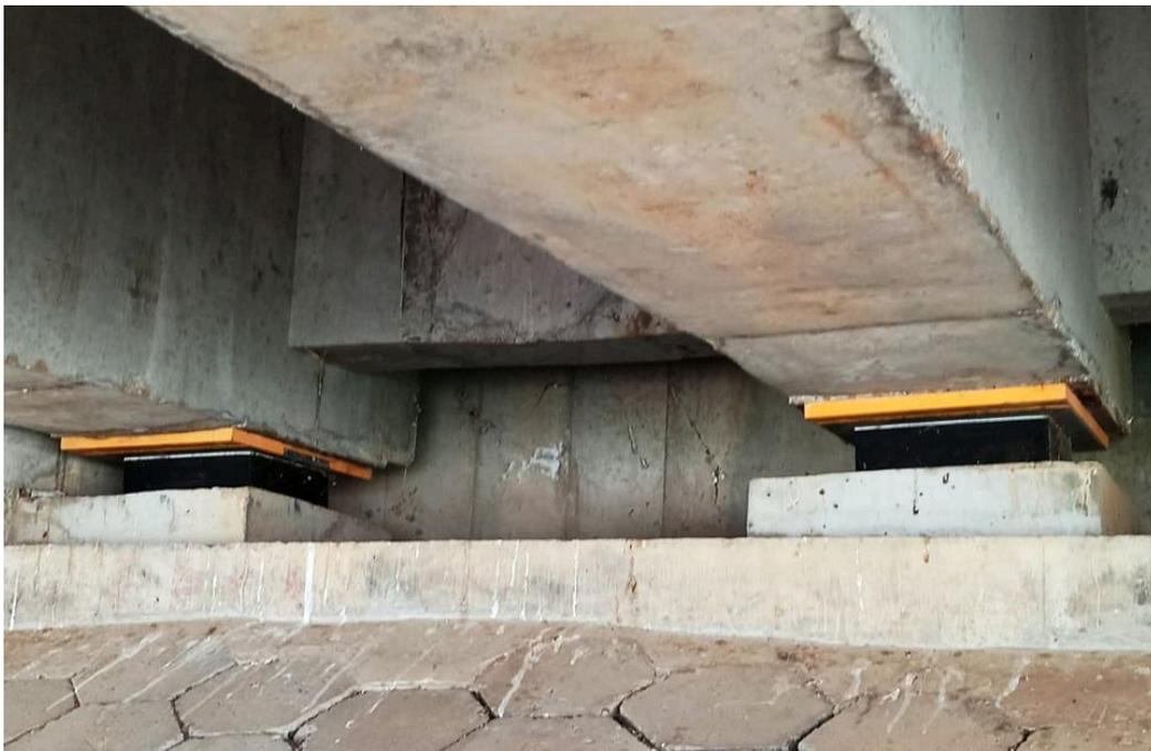
**Figure VII.5:** Appareil d'appui en élastomère fretté
