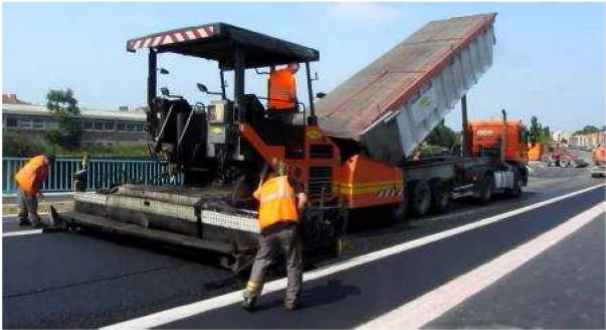
Figure. II. 13 : Mise en œuvre mécanisée à l'aide d'un finisseur. [23]
