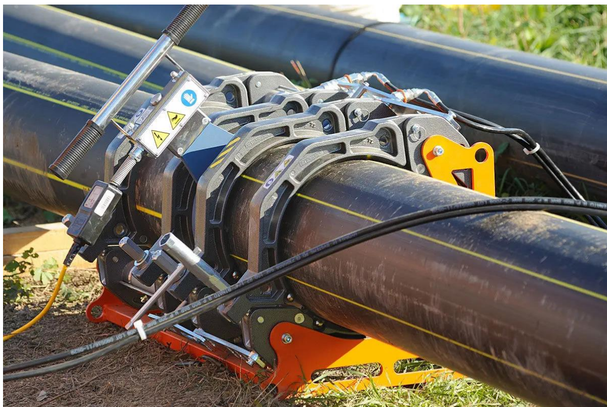
Figure I.4 Soudage Bout à Bout
