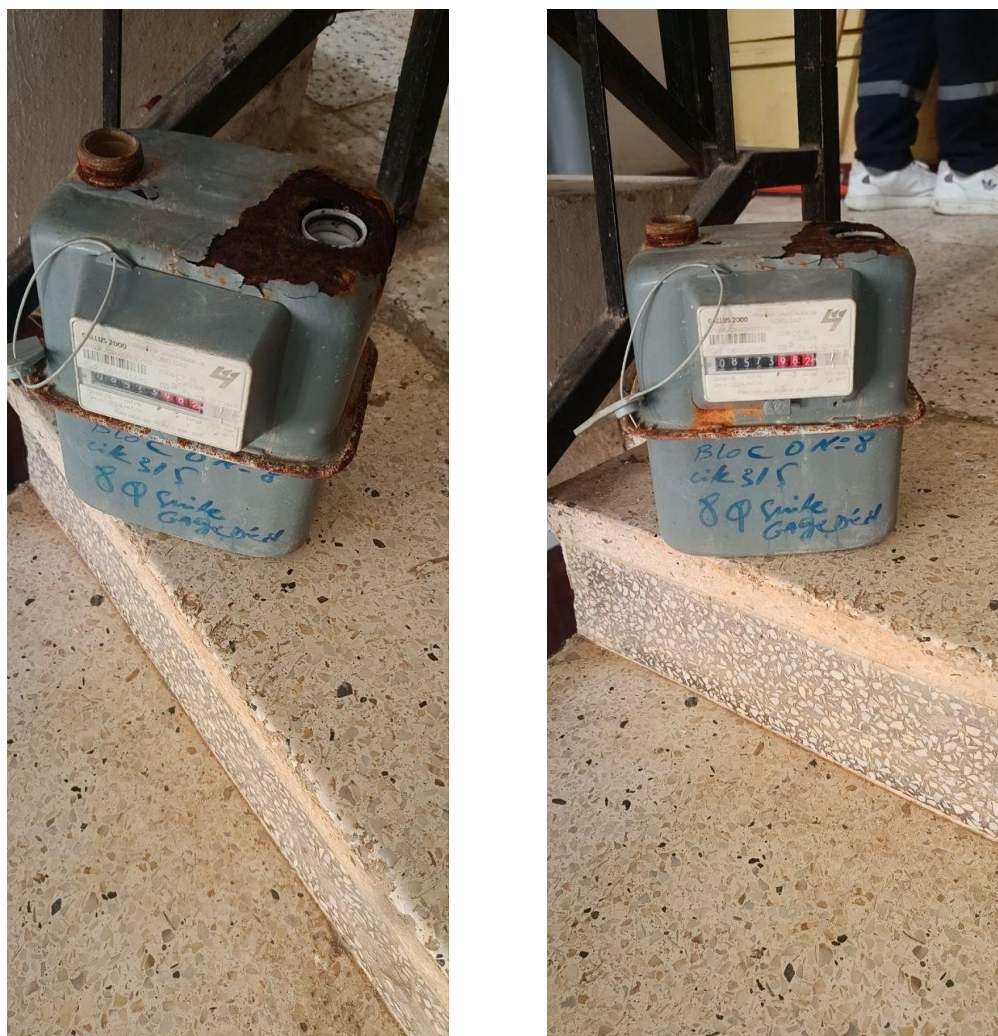
Figure II.1 Compteur corrodé
