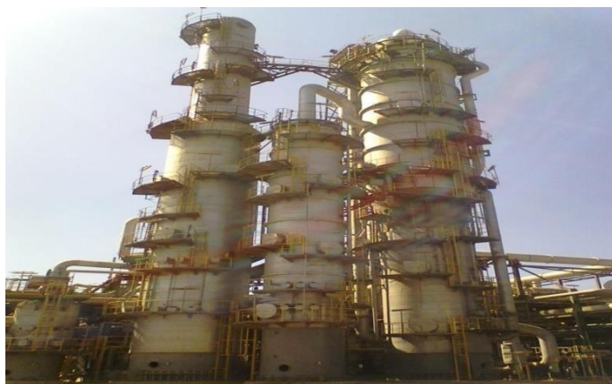
Figure II.2: L'unité de décarbonation
