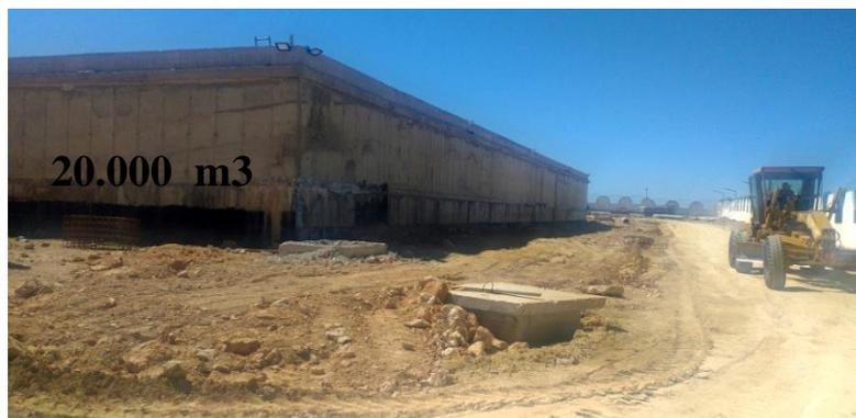
**Figure XXXII : Réservoir semi enterrés [11]**
