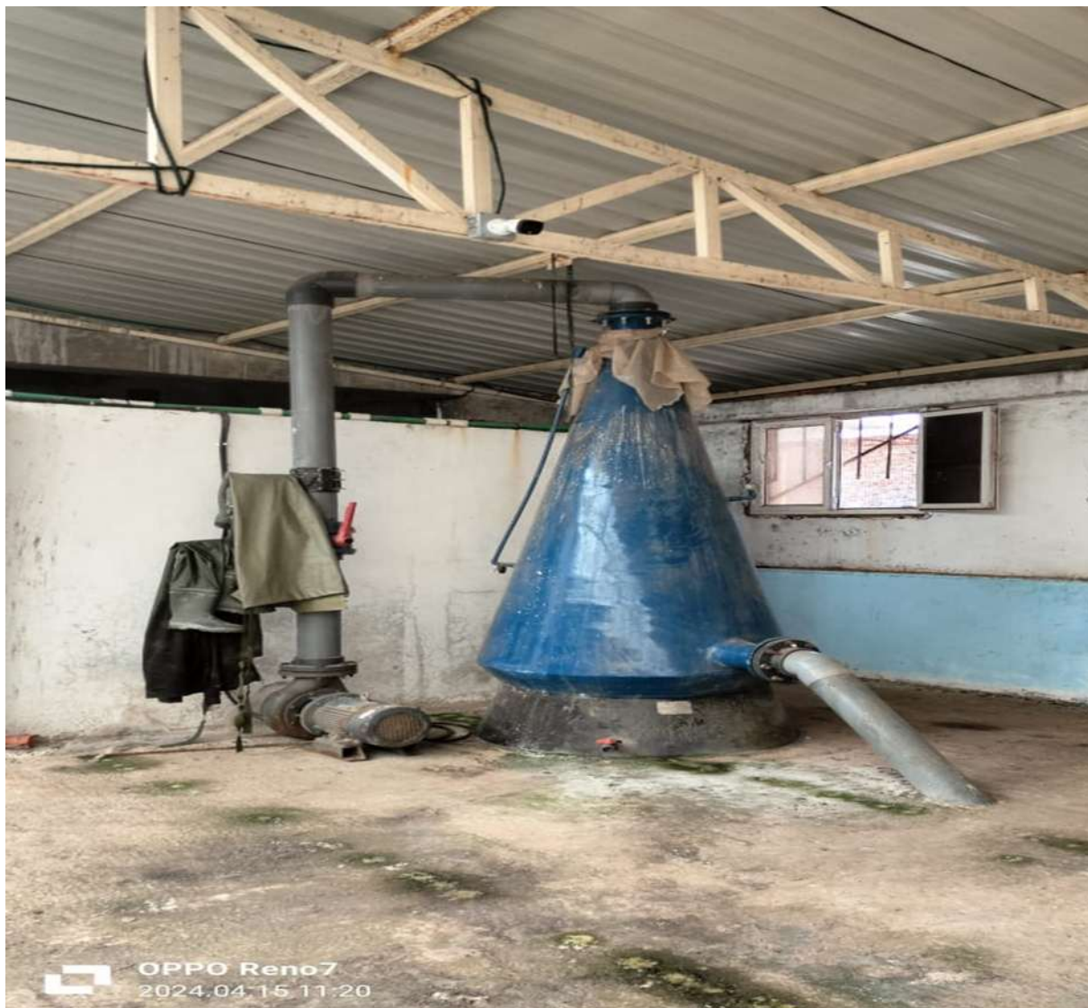
Figure 24 distribution de l'eau par la pompe et par gravité vers les bassins
