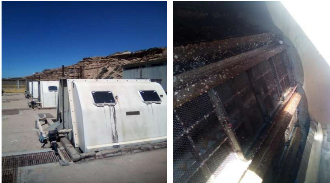
Figure (III.3) : Filtration secondaire (filtres rotatifs).
