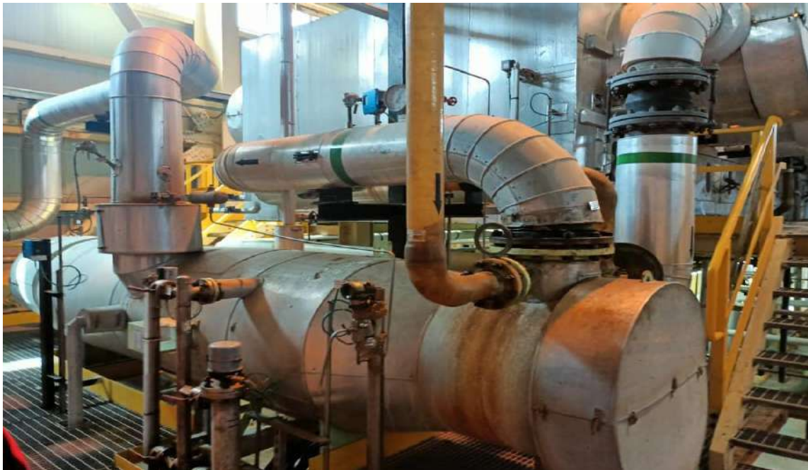
Figure (III.11) : Le réchauffeur de saumure.
