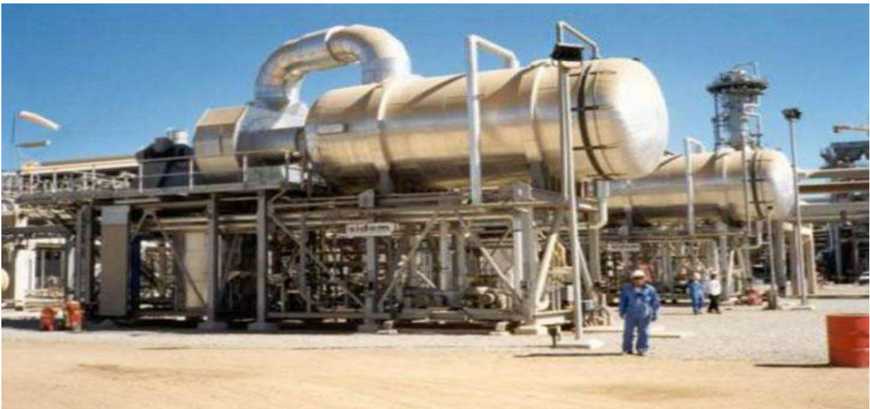
Figure (I.12) : Usine de dessalement Al Ghalilah (Oman) 2 x 500 m 3 /j MVC - source : Veolia – Sidem. [22]
