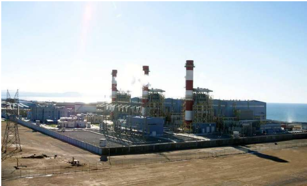
Figure (II.1) : La centrale électrique à cycle combine de TERGA.
