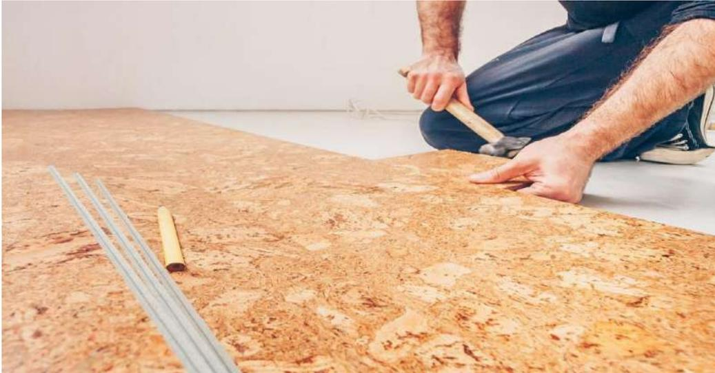
Fig (14) : Isolation du sol d'une chambre froide [19]
