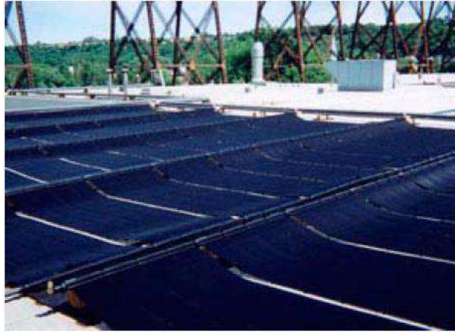
Figure (III, 4) : le capteur solaire non vitré [44]
