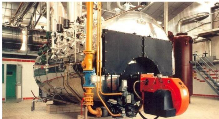
**Figure I.1.** Chaudière à tubes de fumée
