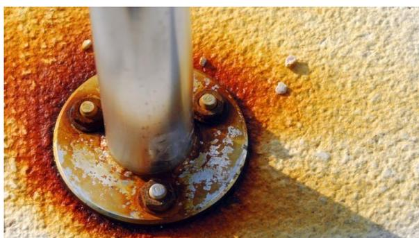
**Figure II.6.** Corrosion galvanique
