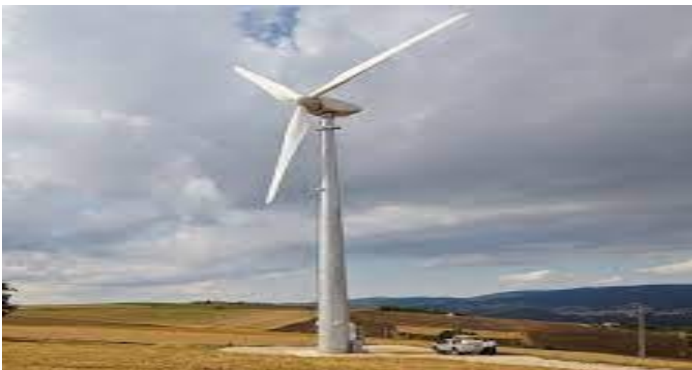
Figure I.7: Aérogénérateur à axe horizontal.
