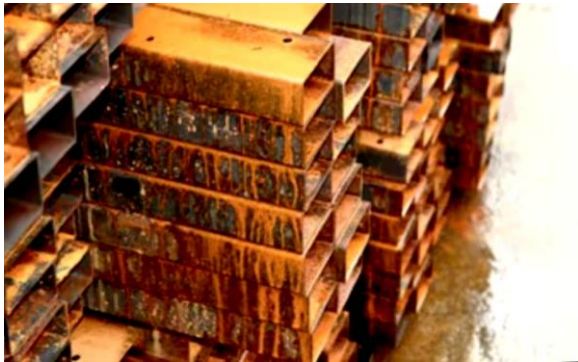
Figure I.5. Exemple de corrosion uniforme [15]
