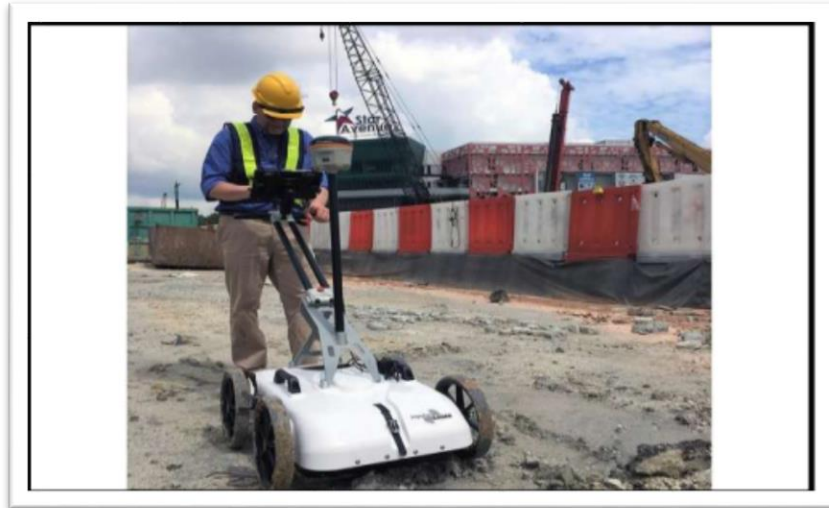
Figure 1. 17 Radar à pénétration de sol (GPR) [23]
