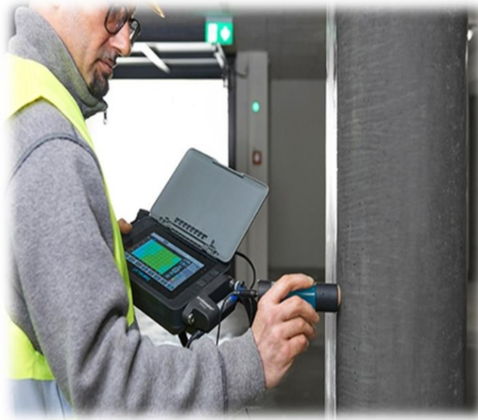
Figure 1. 22 Analyse de la corrosion par CANIN+ [21]
