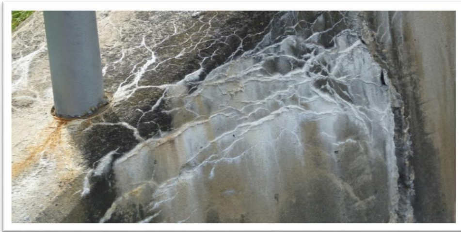
Figure 1. 5 La lixiviation d'un mur en béton [14]
