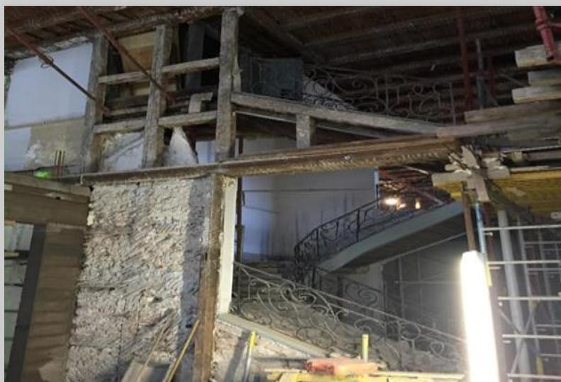
Figure 21 : L'un des deux escaliers protégés au cours du chantier
