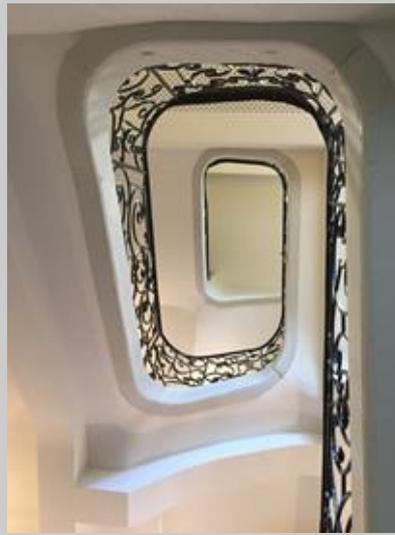
Figure 26 : Renforts en sous-face de l'un des deux escaliers protégés
