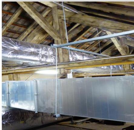
Figure 31 : L'une des deux CTA situées dans les combles
