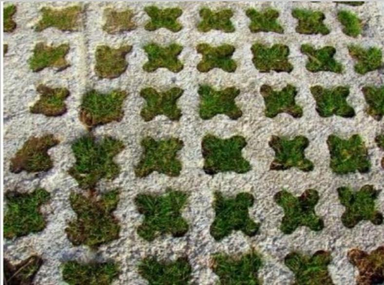
Figure 47 : Gazon en béton
