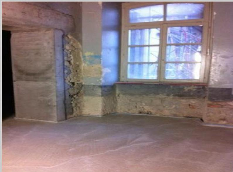
Figure 16: Les murs sont en moellons de grès jaune ET en calcaire
