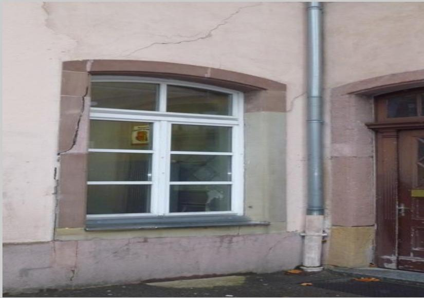
Figure 18 : Lézardes au niveau du Mur Et de l'encadrement
