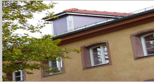
Figure 30 : Chien-assis intégrant les prises et les rejets d'air
