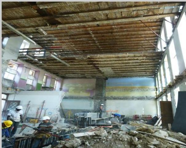
Figure 29 : Suppression des deux niveaux de planchers intermédiaires
