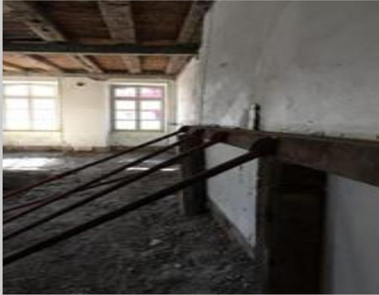
Figure 17 : Consolidation du Mur en cours de chantier
