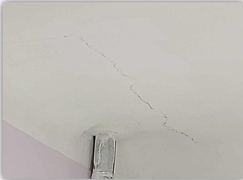
**Photographie 3: les fissurations dans les classes**
