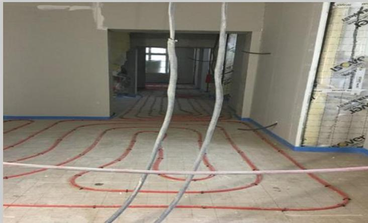
Figure 32 : À droite : présence d'un frein-vapeur hygrovariable mais absence d'isolation au niveau de l'ébrasement des fenêtres. En bas : mise en place du plancher chauffant au rez-de-chaussée.
