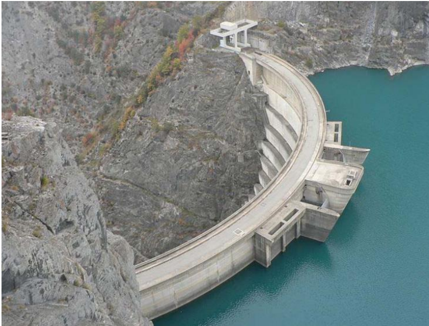
Figure 4. 3 Barrage à voûte épaisse-Monteynard, France (H =153m)
