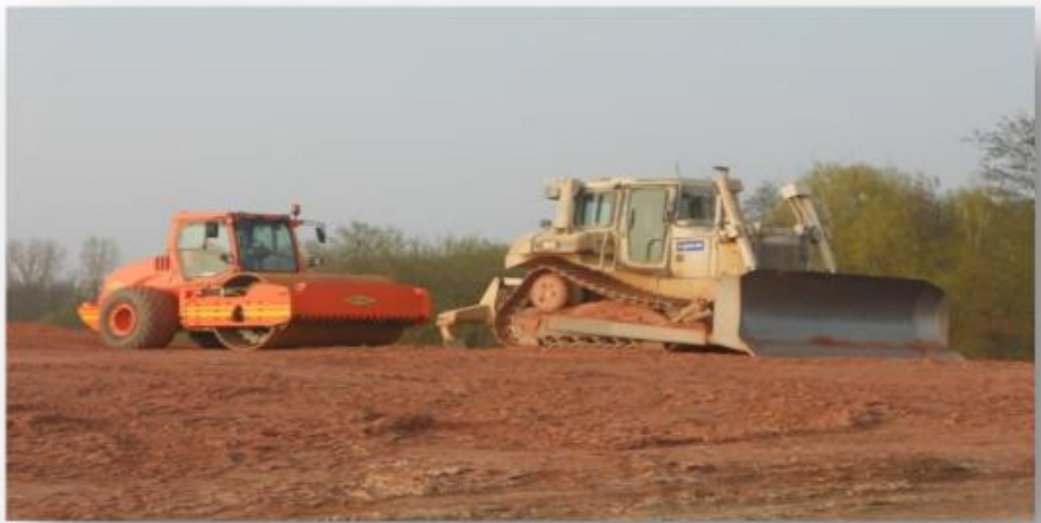
Figure I.12. Utilisation des boues de dragage dans les remblais routiers
