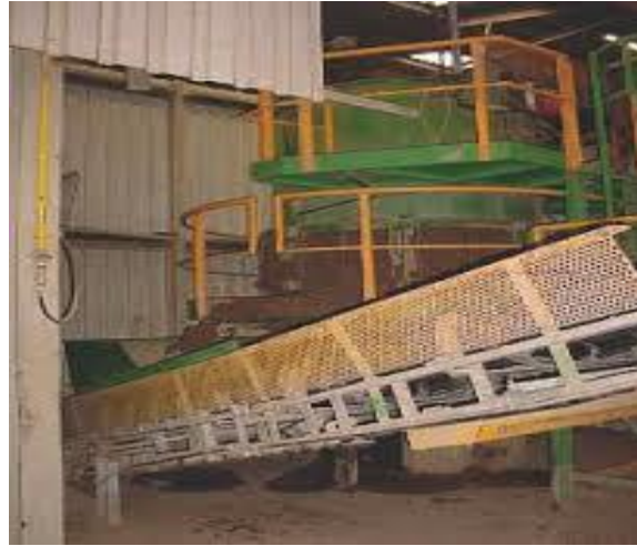
Figure III.4. Le broyage et malaxage d'argile dans la briqueterie
