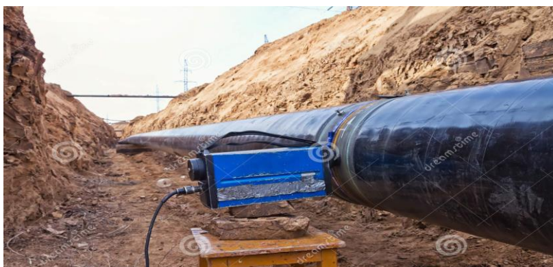
Figure 20 : contrôle par radiographie
