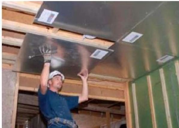
**Figure II.10 : Modèle de panneaux de MCP [33]**
