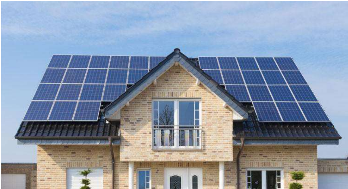
Figure I-16 : Les panneaux solaires photovoltaïques des cellules amorphes
