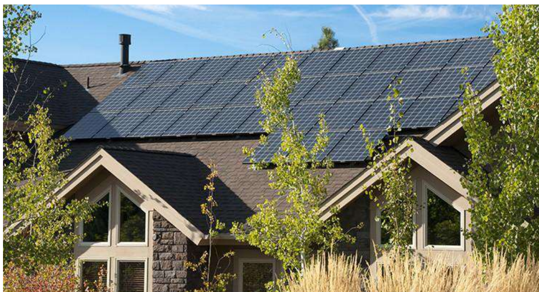
Figure I-15 : Les panneaux solaires photovoltaïques des cellules multifonctions
