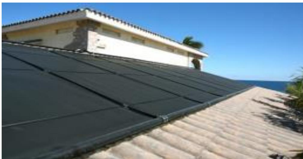
**Figure 1.3 :** Capteur solaire non vitré [3]
