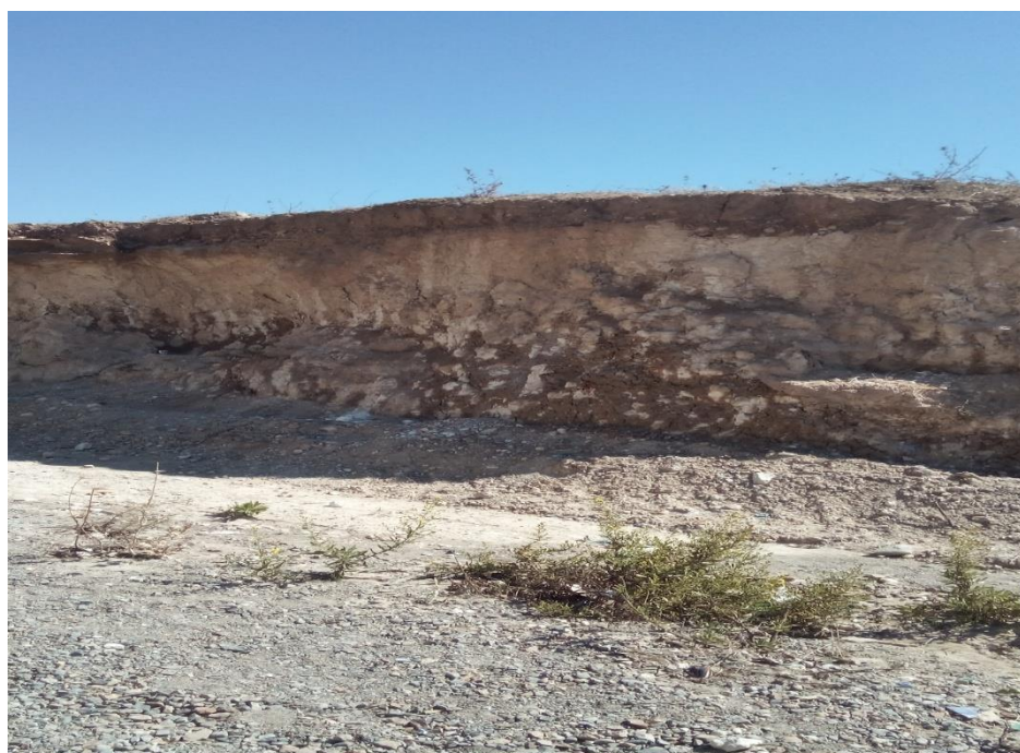
Figure IV.10 Photo Argile sableuse (Salle de vente enchère –Domaine-sud-est II) -06/10/2019.
