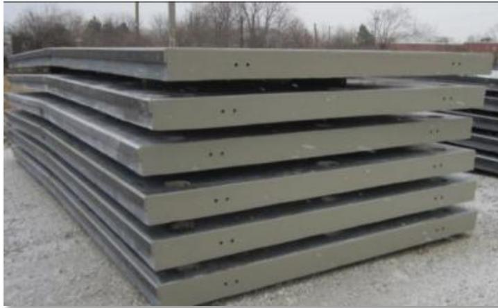
**Fig. II. 10.** Tablier en polymères renforcés de fibres [201].
