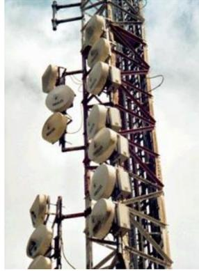
**Fig 5 Faisceaux Hertzien [5]**
