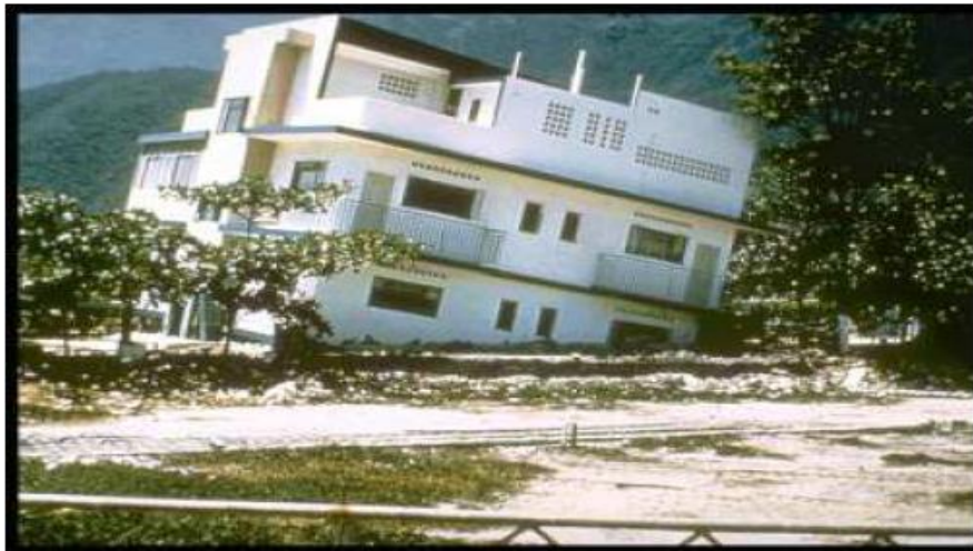
Figure 21.1 Liquéfaction des sols Séisme de Caracas, Venezuela 1967 [4]
