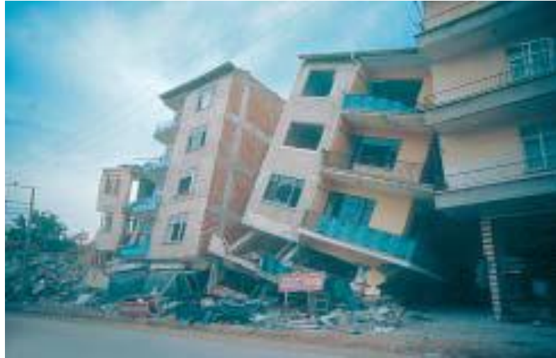
Figure 7.2 Les mécanismes de colonnes sont souvent inévitables lorsque le rez-de-chaussée est flexible (Izmit, Turquie, 1999) [5].
