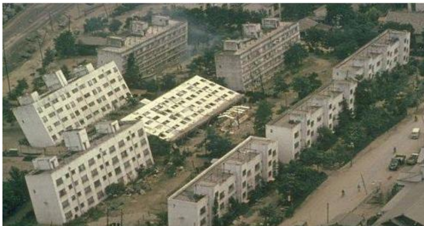
Figure 22.1 Liquéfaction des sols, voire renversement du Bâtiment Séisme de Niigata 1964, au Japan [4]
