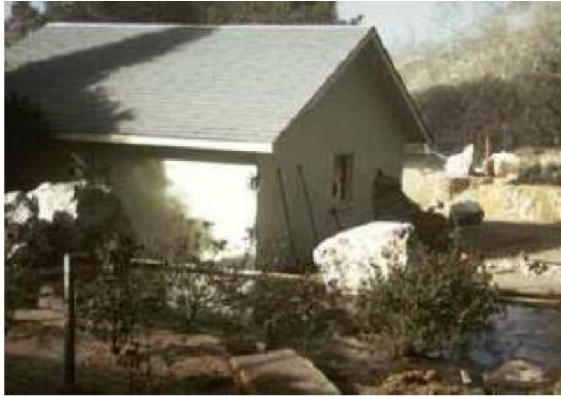
Figure 27.1 Glissement et Eboulement des Roches [4]
