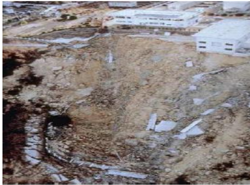
Figure 23.1 Glissement du Terrain (Kobe 1995) [4]
