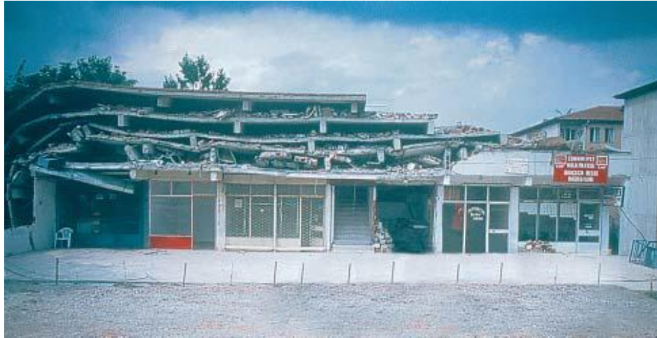
Figure 9.2 Tous les étages étaient trop flexibles (Izmit, Turquie, 1999) [5]
