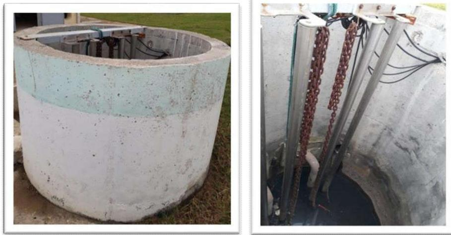
*figure 11 : Poste toutes eaux (vue de l'extérieur et de l'intérieur).***photo original**
