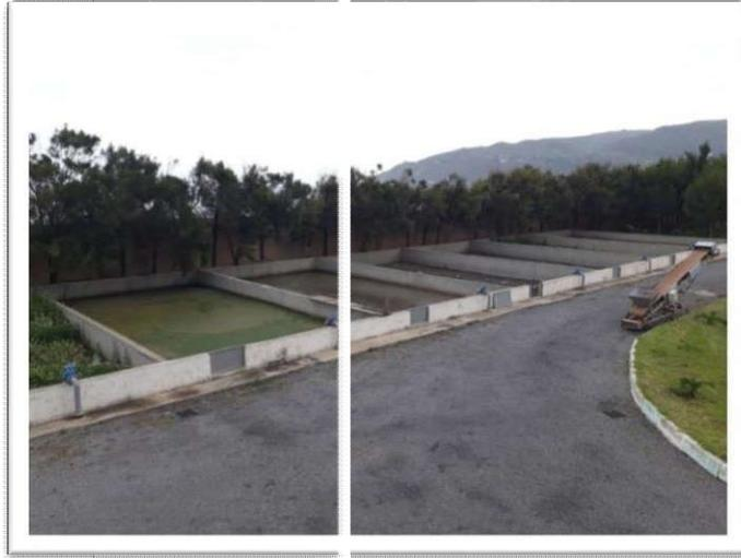
*Figure 15 Lits de séchage.* **photo original**
