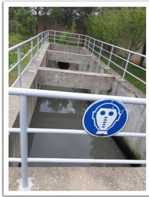
Figure 2 Arrivée des eaux et déversoir d'orage. *photo original*
