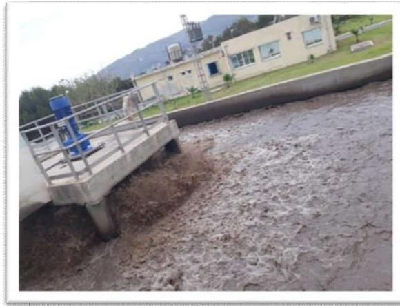
figure 7 Bassin d'aération et aérateur de surface.*photo original*
