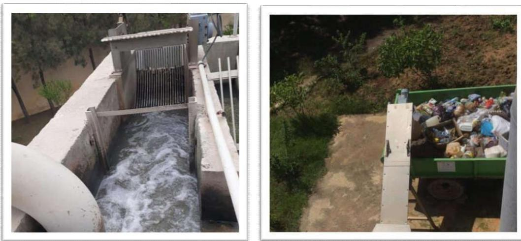
figure 4 Dégrilleur automatique.
