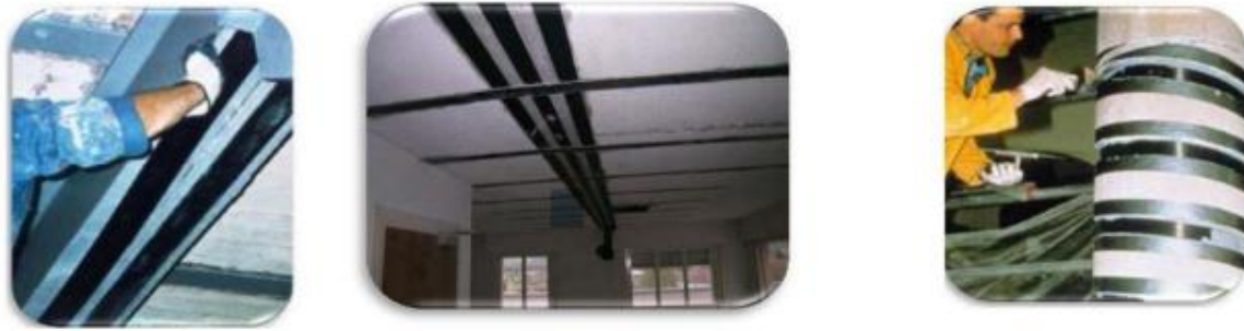
Figure (I.02) : Principales applications de renforcement par composite collés sur ouvrages [Riad BENZAID, 2015]
