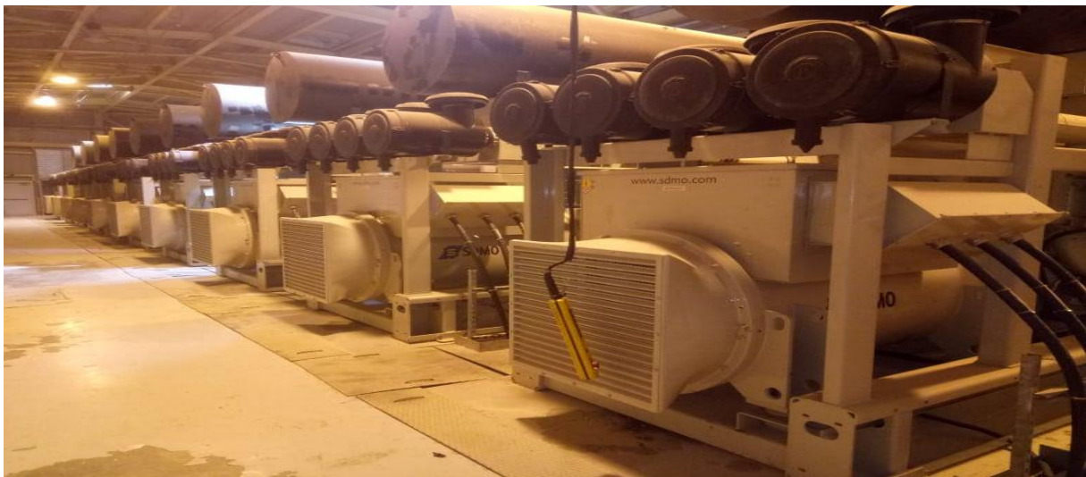
Figure 17 système de secours (Black Start)
