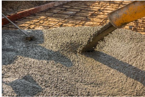
Figure 15 : Béton auto plaçant
