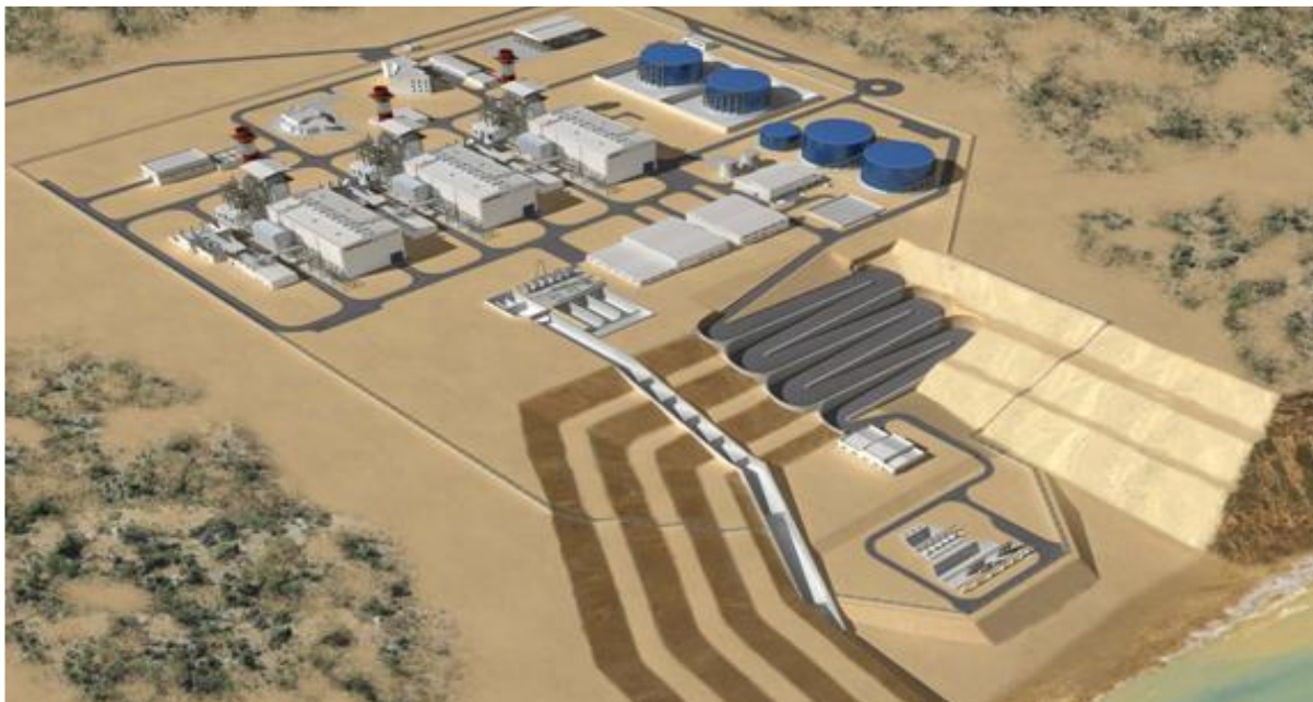
Figure 02: Vue générale de la centrale Terga
