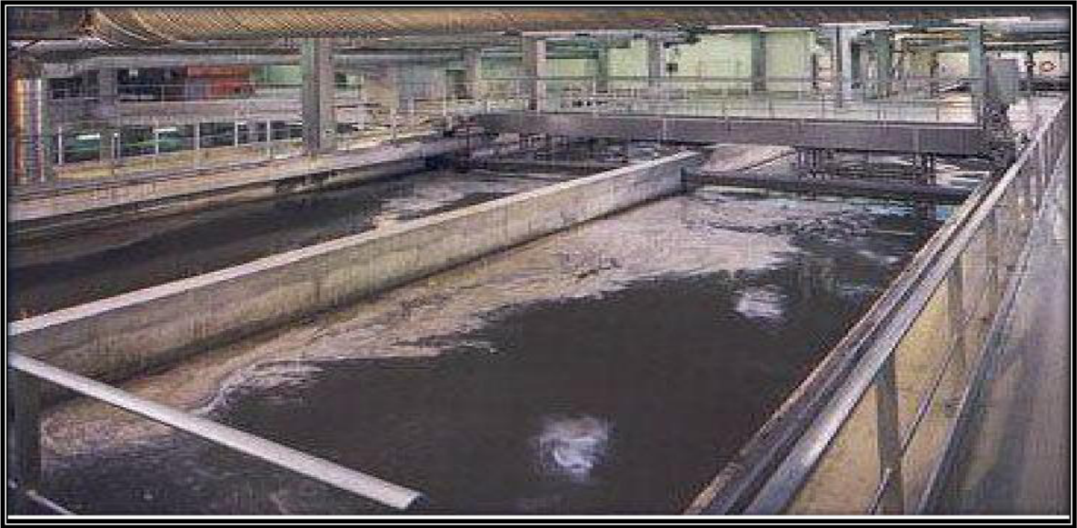
Figure 33 : Dessableur -dégraisseur rectangulaire (32)
