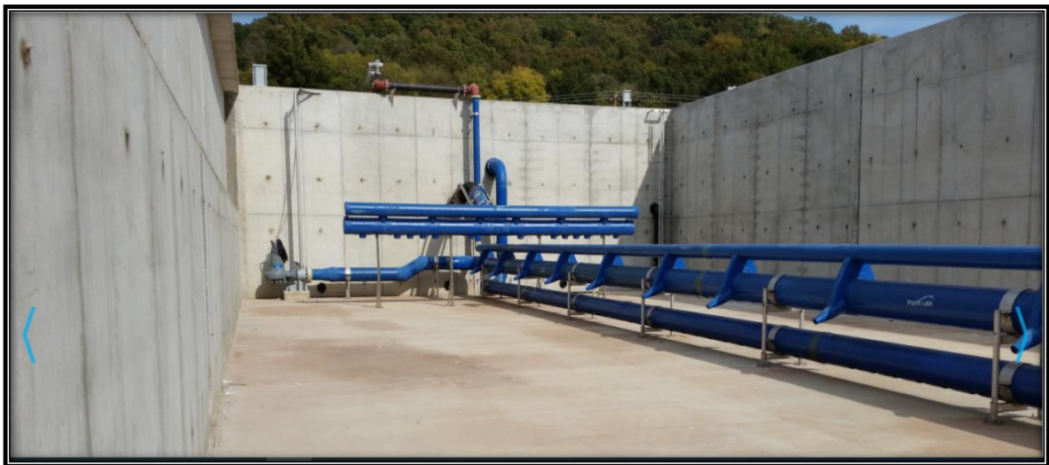
Figure 34 : Réacteur discontinu séquentiel Eco Cycle SBR (33)
