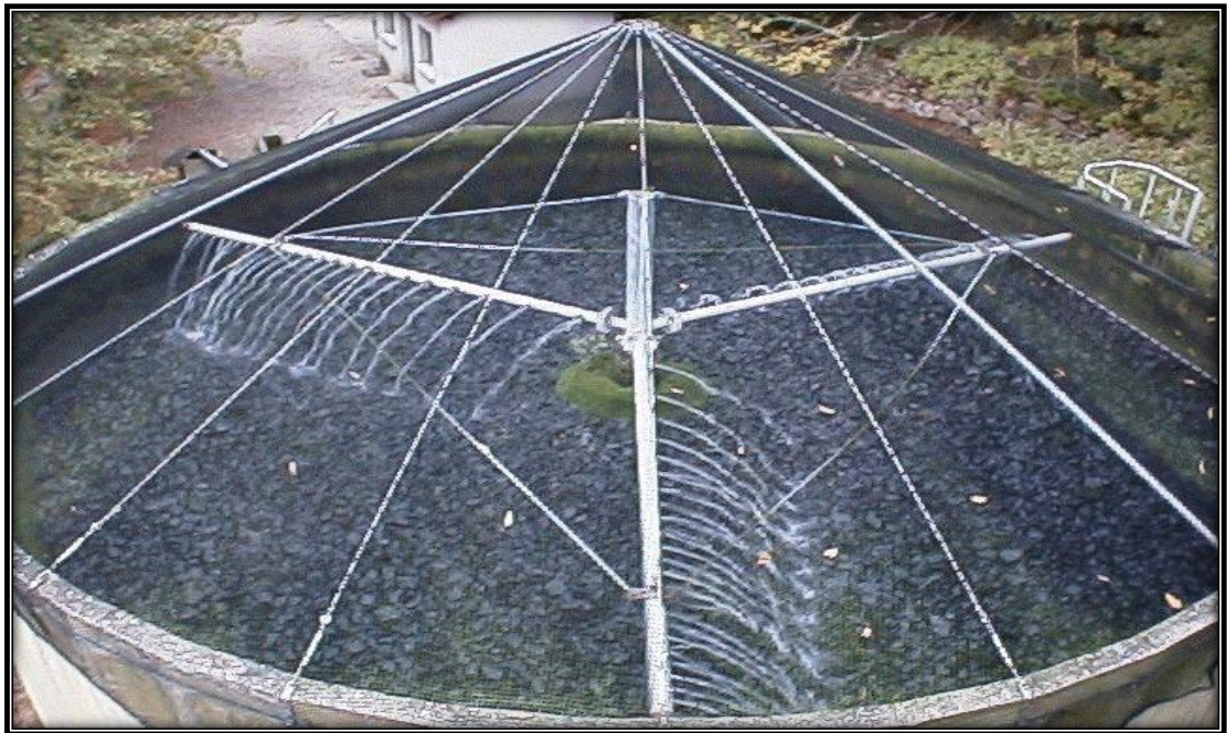
Figure 11 : Lit bactérien avec garnissage traditionnel
