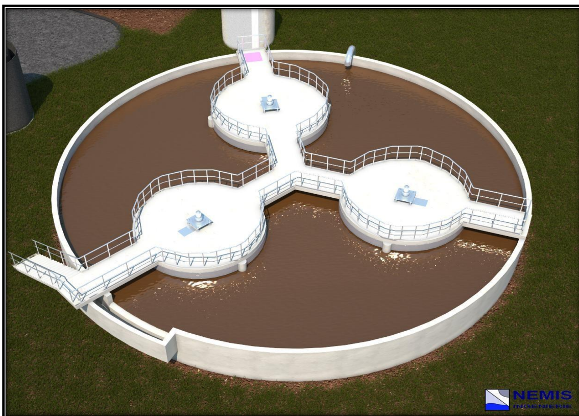
Figure 2 : vue zoomée d'un bassin d'aération
