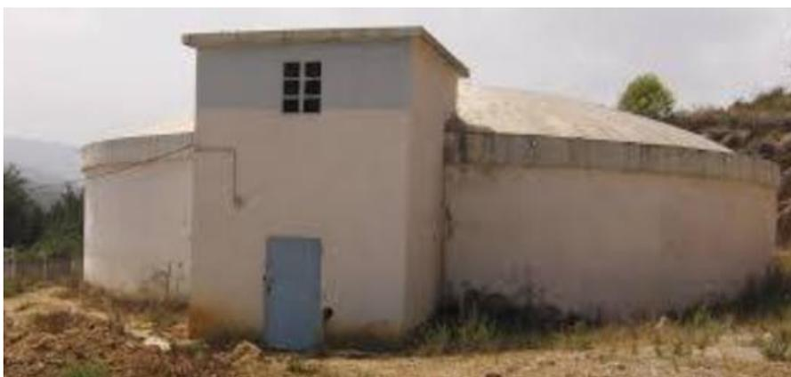
**Figure 2:** Présentation d'un réservoir circulaire avec coupole.
