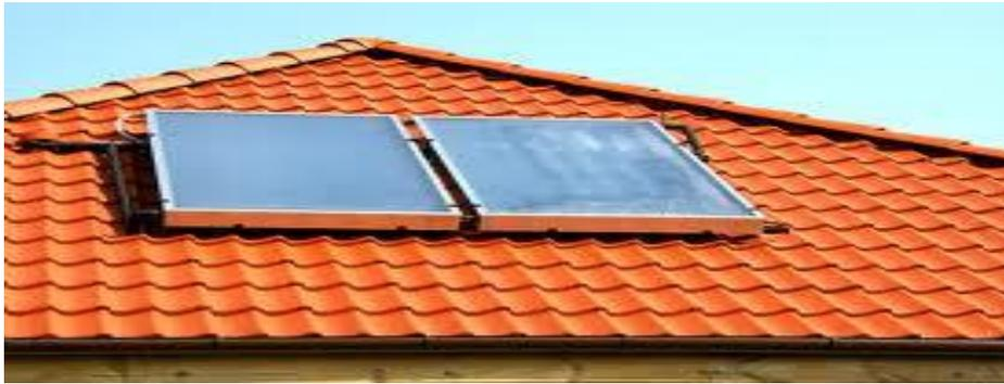
Figure2 : Chauffe-eau solaire a circulation forcée.
