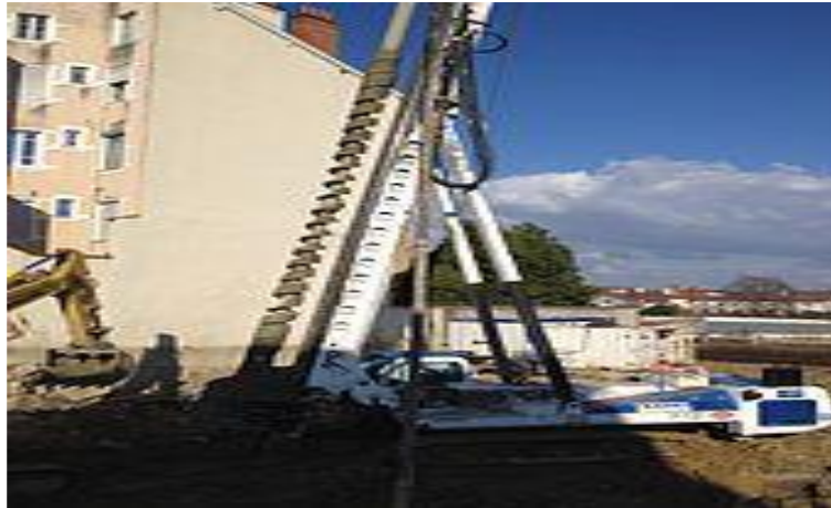
Figure 3.17: Machine à pieux ou foreuse sur un chantier de fondation spéciale. [7]
