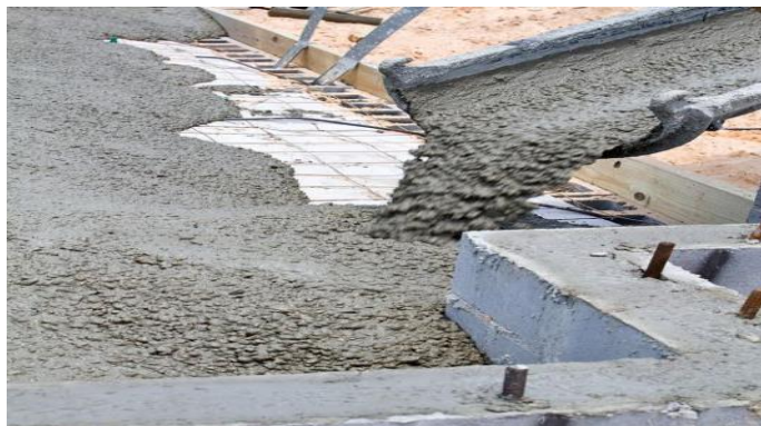
PHOTO 15 : béton auto plaçant
