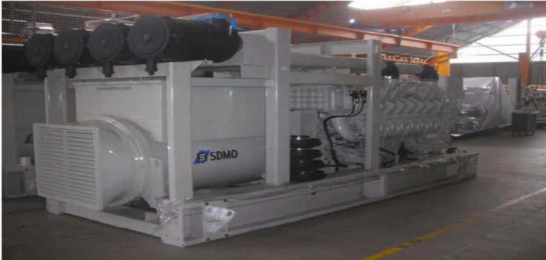
**Figure I-8** Groupe Electrogène de secours [12]
