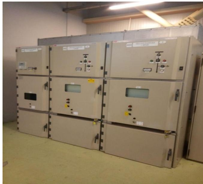
**Figure II-4** Armoires de Disjoncteur du SSD & SES [29]
