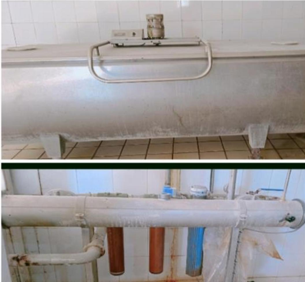
**Figure 03.Photo 01.**Équipement d'épuration de l'eau utilisée dans la préparation du lait
