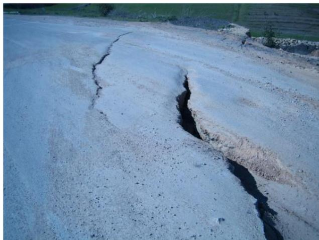
Figure 74: Fissures traversant la chaussée (Glissement au PK 25+000). (CTTP, 2014)
