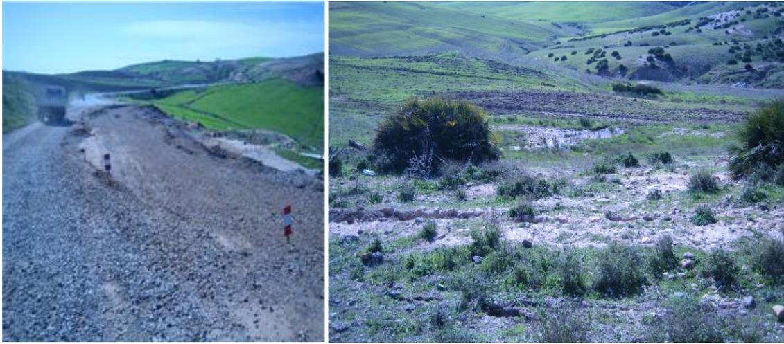
Figure 71: Fissures d'affaissement visible sur le remblai du côté aval (Glissement au PK 24+000). (CTTP, 2014)
