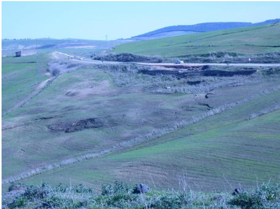
Figure 72: Zone de fluage au niveau du talus aval de la chaussée (Glissement au PK 24+000). (CTTP, 2014)
