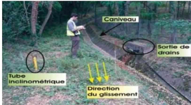
Figure 37: Drainage des eaux de surface à l'aide d'un caniveau. (Bengourain et Tounsi ,2018)
