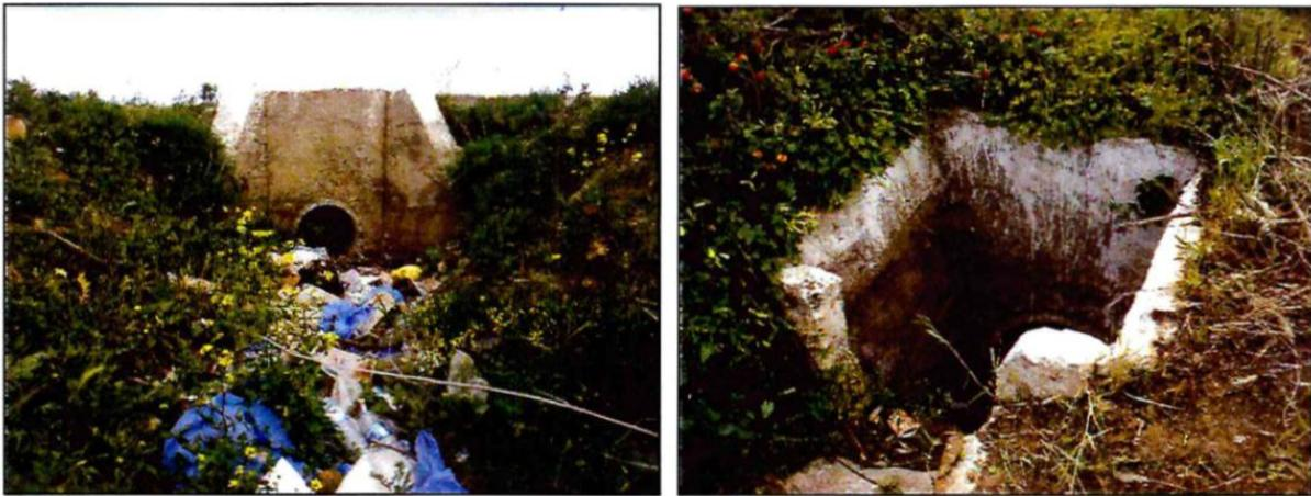
Figure 57: Drainage inopérant et insuffisant. (SETS 2018)
