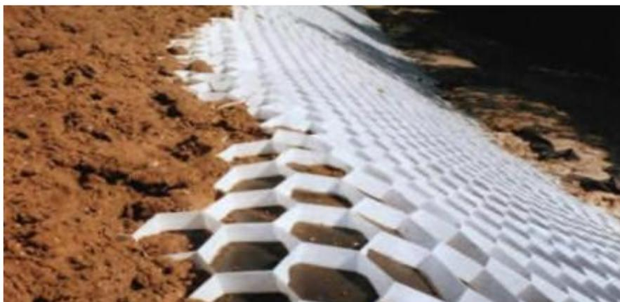
Figure 46: Renforcement par géotextiles. (Nemmiche et Ougherb, 2015)
