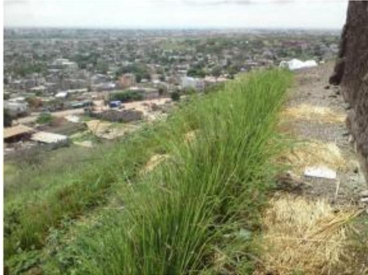
Figure 41: Pente stabilisée à l'aide de Vétivers du monument de la Renaissance Africaine au Sénégal. (Desodt et al, 2017)
