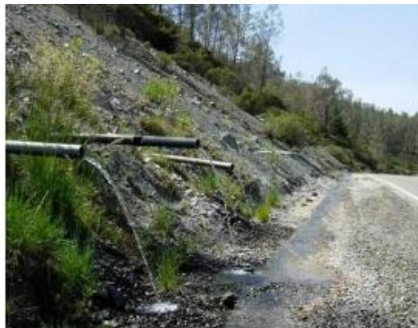
Figure 36: Drainage de talus par barbacanes. (Desodt et al, 2017)
