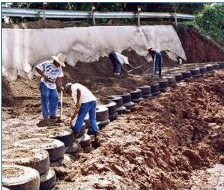
Figure 47: Renforcement par Pneu-sol. (Nemmiche et Ougherb, 2015)
