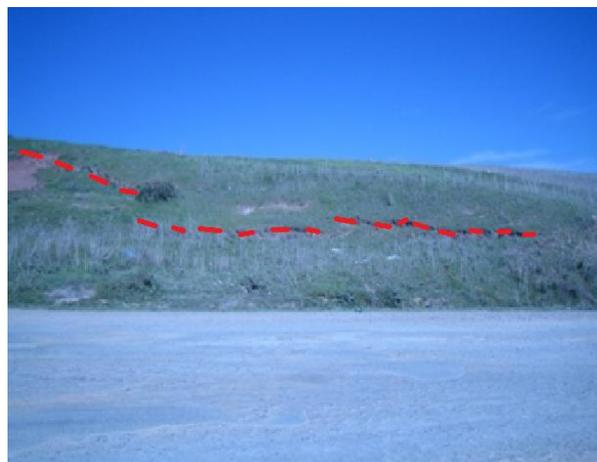
Figure 70:Fissures d'affaissement visible sur le remblai du côté amont.(CTTP, 2014)
