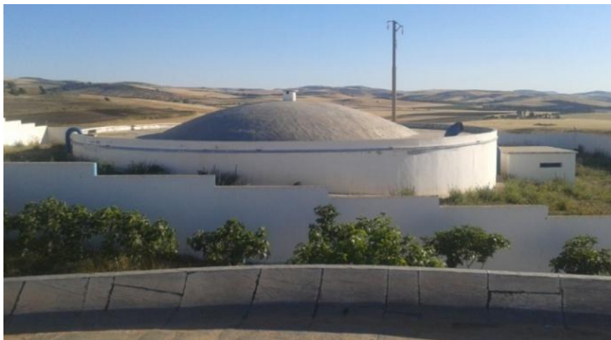
Figure 2.2 : Réservoir de stockage ITMA
