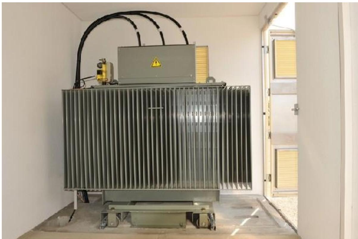
**Figure I.1 :** Transformateur de puissance
