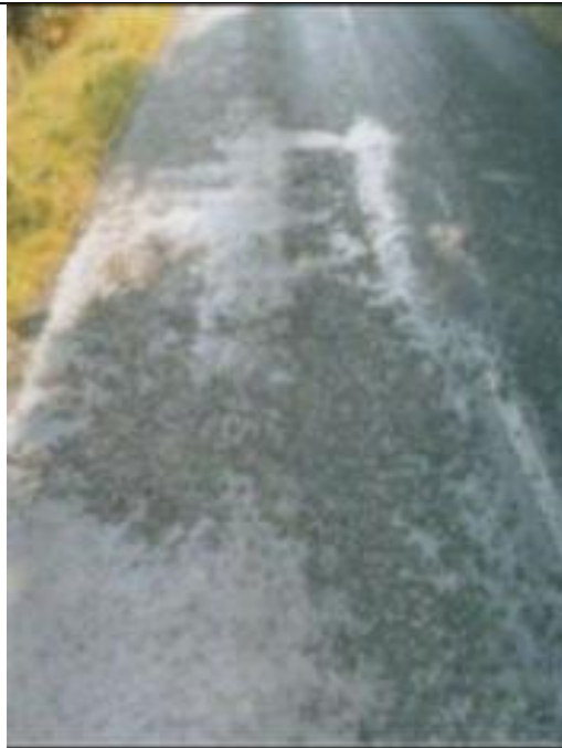
Figure 44:Photo pris de dégradation de famille remontée
