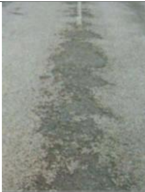
Figure 43: Photo sur dégradation de type du plumage
