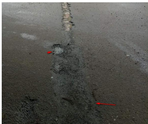
Figure 33: Photo prise sur les dégradations due aux stagnations des eaux pluviales (centre de Ville d’Ain témouchent)
