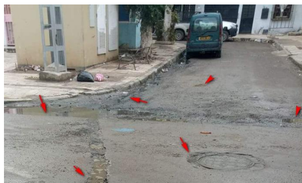
Figure 33: Photo prise sur les dégradations due aux stagnations des eaux pluviales (centre de Ville d’Ain témouchent)
