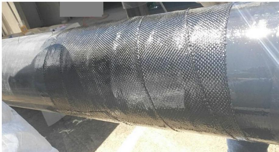
**Figure II- 7 : Réparation d'un pipe avec patch en composite**
