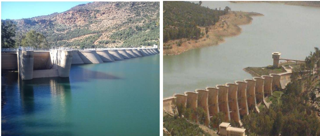
Figure II.1 : Vue général du barrage de Béni-Bahdel [10]
