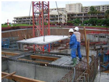
**Figure I.24:** Pose d'une prédalle.
