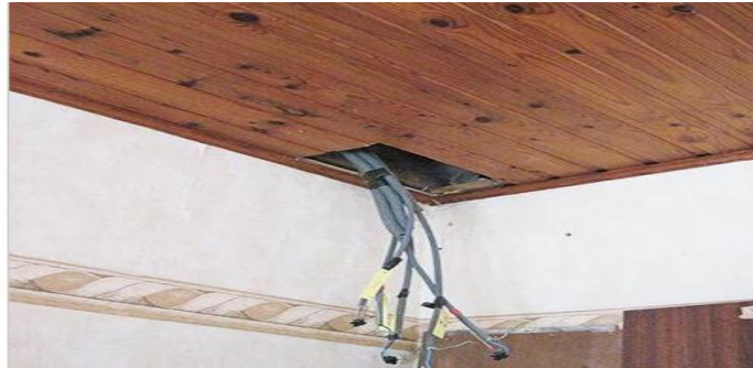
Figure IV.24 : Pose dans les vides de construction [28]
