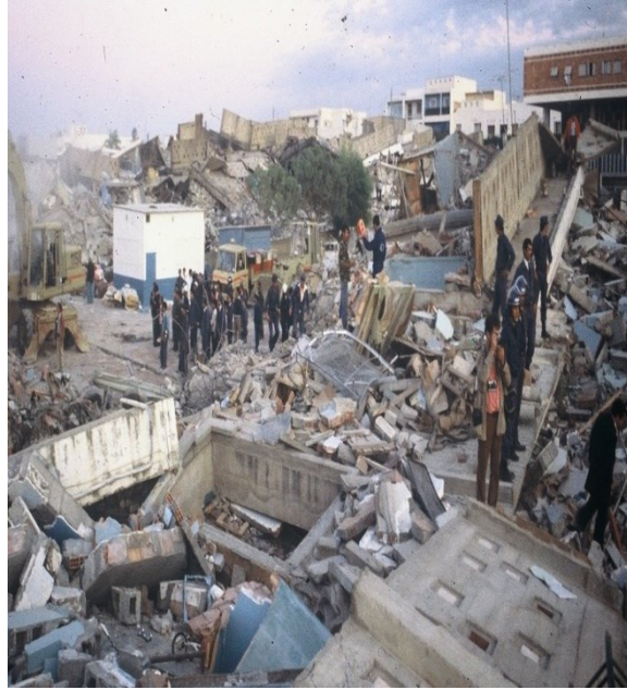
Figure 1: Les damages des structures causées par le phénomène de liquéfaction
