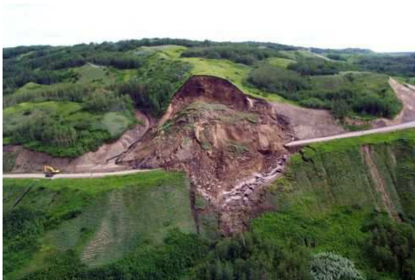
Figure I. 1: Glissement de terrains Bejaïa 2012, [8]
