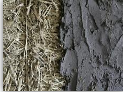
Figure 16: bois et remplissage paille dans les parois
