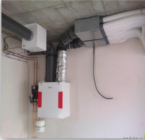
Figure 56:principe de fonctionnement de VMC double flux
