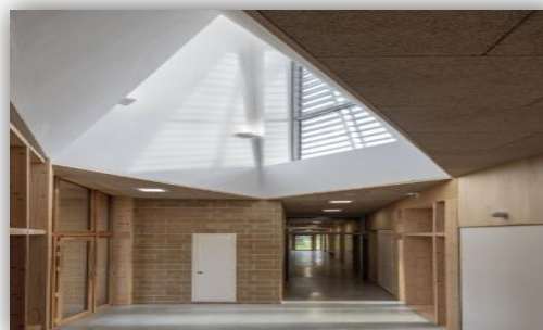
Figure 34: ventilation hygiénique avec les ouvertures verticales mono-orientées
