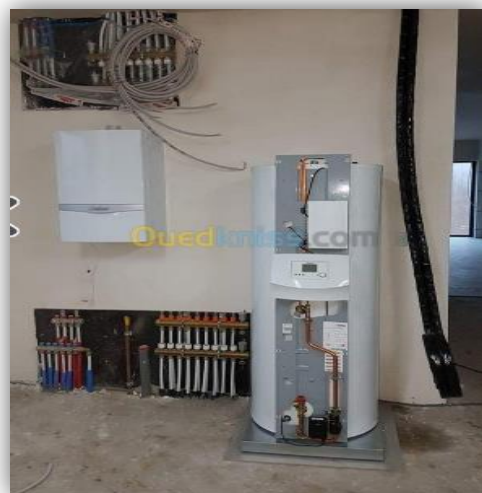
Figure 58:fonctionnement de pompe à chaleur air/eau (pac)
