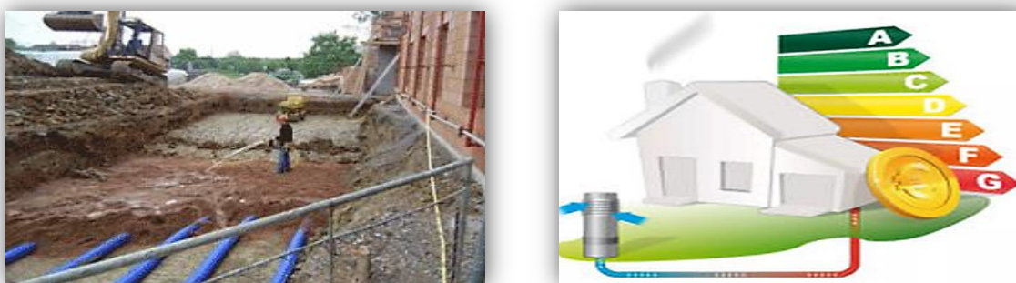
Figure 20: puits climatique
